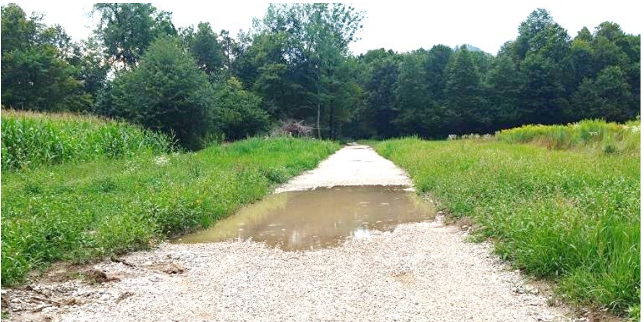
Slika 17. Še ena velika luža, ki jasno nakazuje na posedanje in nestrokovno zasipanje
