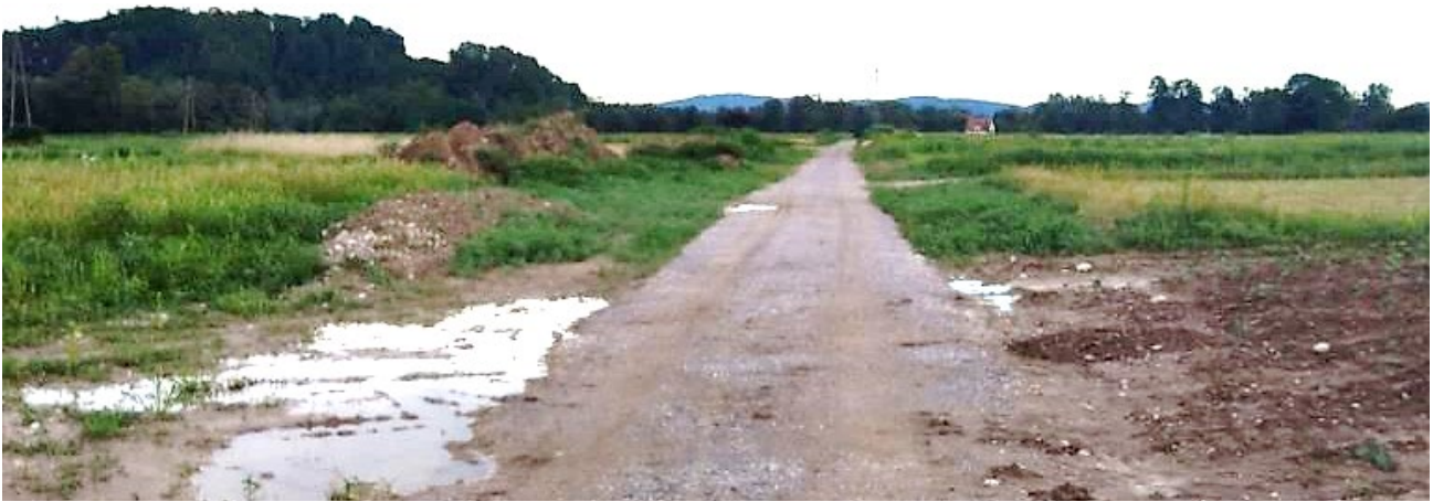
Slika 16. Ne urejen teren, ki se poseda mesec dni po umiku gradbincev in varnostnih služb
