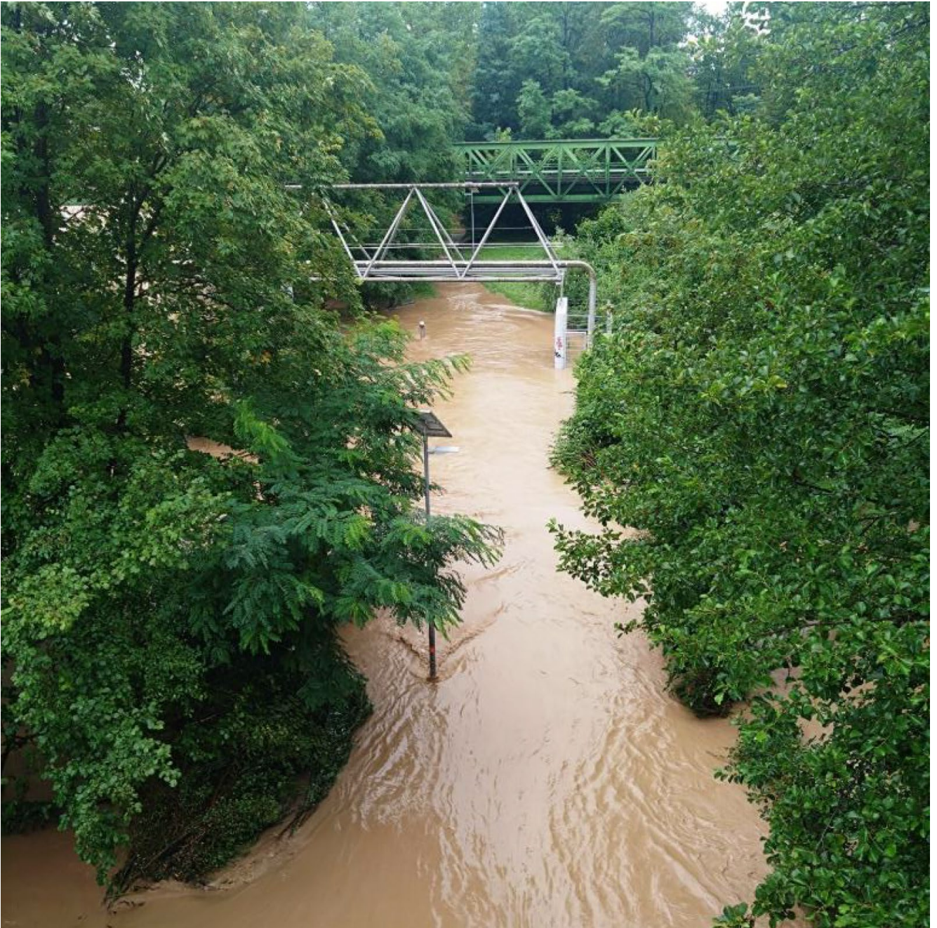
Slika 18. Trasa Kanala C0 na križanju s plinovodom poplavljena. Zaznane razpoke na trasi skozi njih pa viden zaščitni beton, ki je očitno počen in so ga poškodovali premiki in vzgon in posedek cevi.
