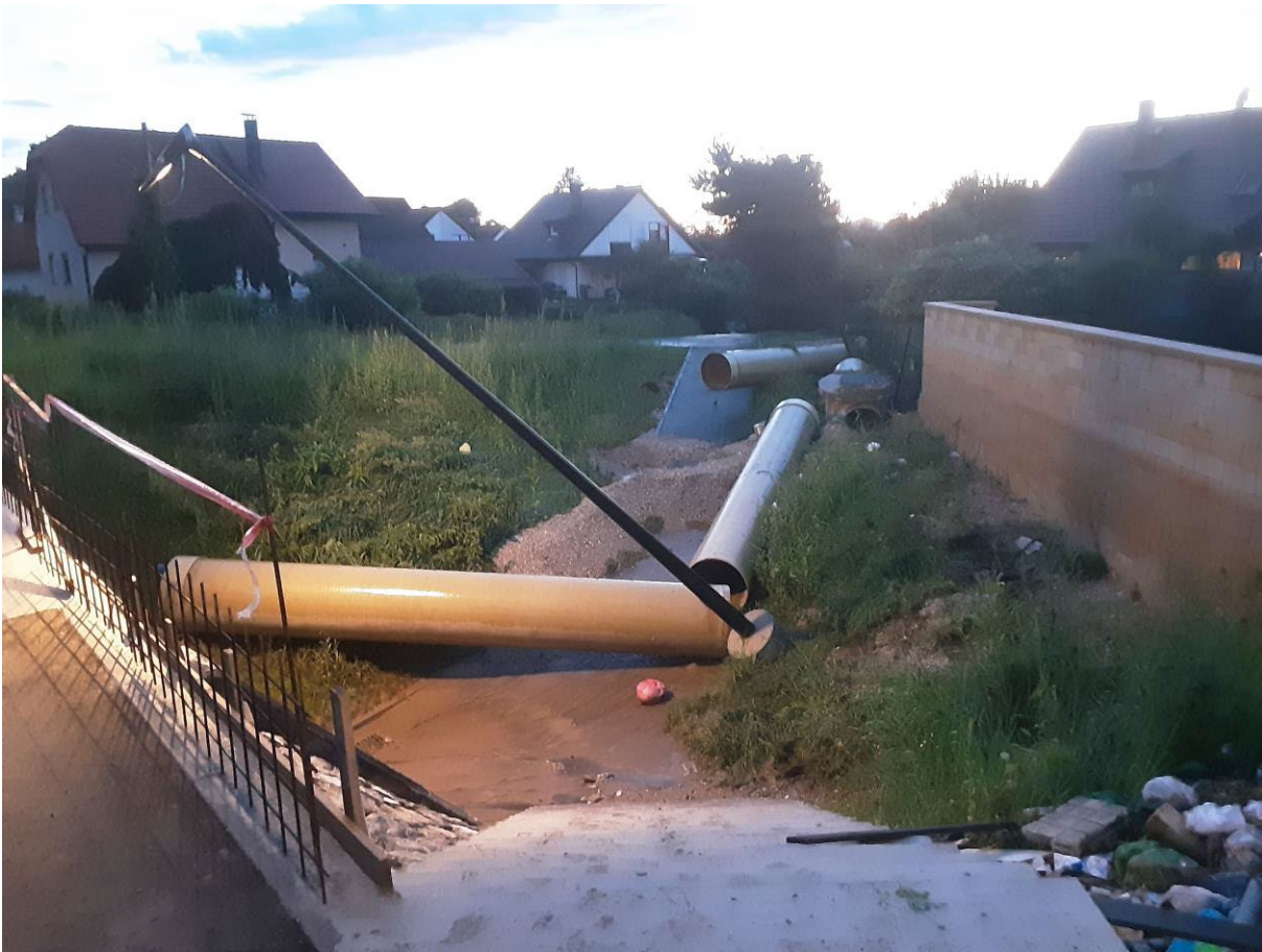
Slika 19. Naselje Sneberje plitko položen desni pritok Kanala C0 je »izplaval«
