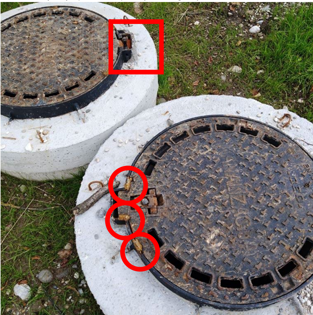
Slika 12. Napačna višina jaškov, polomljeni pokrovi, zavarjeni jaški
