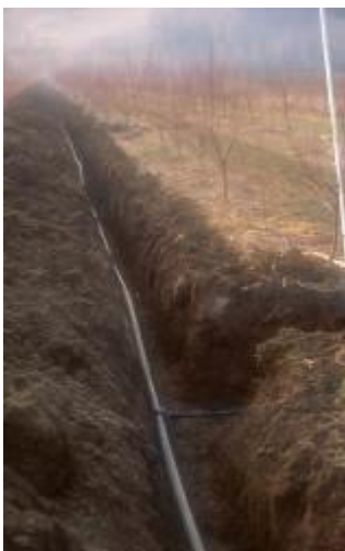
Slika 31: Izgradnja stabilnega oroševalnega sistema.
